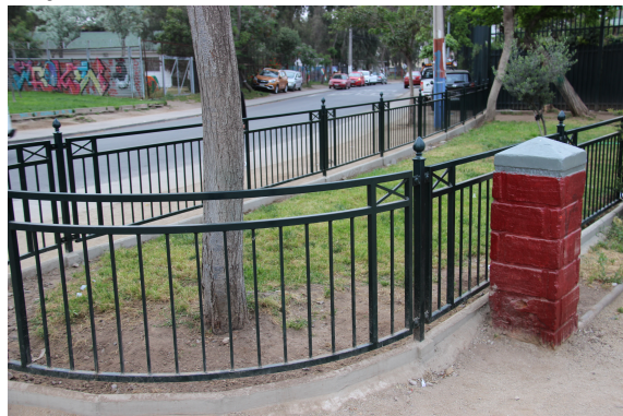
Reja / cerco perimetral de la plaza
